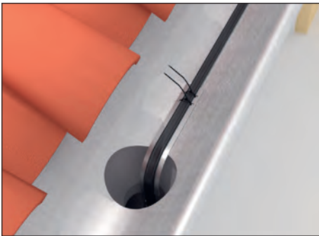
Übergang von Dachrinne in Fallrohr.
