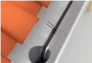
Kantenschutz am Übergang von Dachrinne in Fallrohr.
