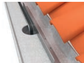
T- Traverse am Übergang von Dachrinne in Fallrohr.
