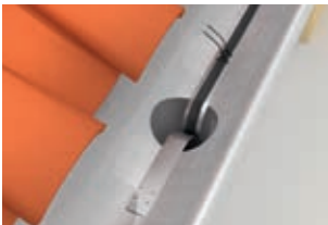
Kantenschutz am Fallrohr zur Zugentlastung.
