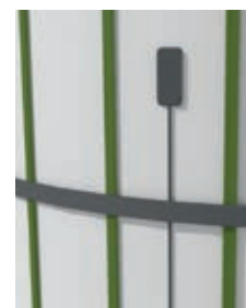
Temperaturfühler montiert am Tank
