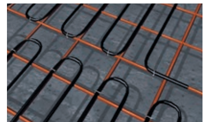
Heizmatte direkt verlegt auf oberer Bewehrung
